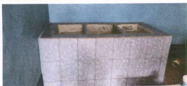
Foto 17: Fabricación de pila de cemento de dos lavaderos por deterioro de la existente y ya no tiene reparación por el materiales de fabricación en mal estado fundida de concreto.
