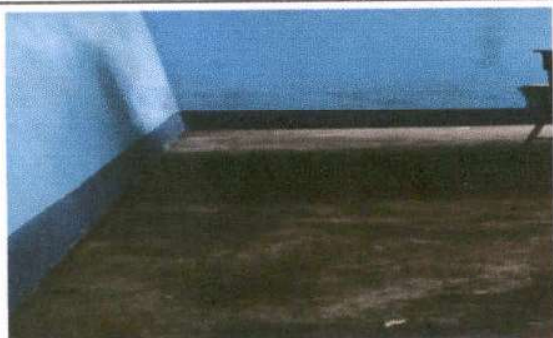
Foto 3: Piso de torta de concreto. 40 metros
