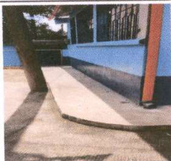
Foto 11: Reparación de banqueta de concreto por filtración de agua al salón de clase del exterior al interior. 12 m².
