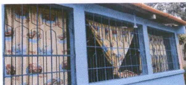
Foto 8: Mantenimiento de balcones de metal, lijado aplicación de pintura. 8 m².
