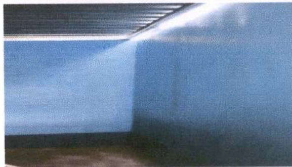
Foto 4: Pintura en muros interiores y exteriores. 60 metros
