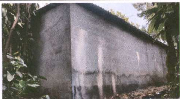
Foto 21: Construcción de muro perimetral de block 6 metros de ancho por 6 metros de largo y altura 2.70
