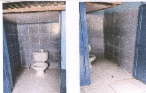
Foto 16: En los sanitarios se colocó azulejo para una mejor higiene y servicio. 15 metros.
