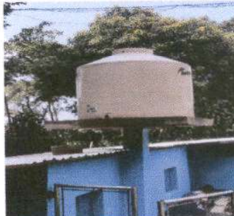
Foto 6: Depósito de agua 2,500 lt, suficiente a consecuencia que el servicio de agua es inestable por mas de 15 días.
