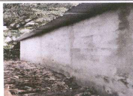
Foto 18: Se repelló la parte externa de los baños ya que se filtra agua y el deterioro es constante. 30 metros.
