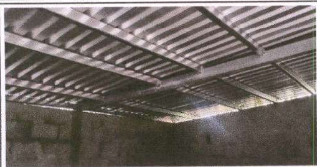
Foto1. Colocación de lámina y estructura de metal con medidas de 40 M2
