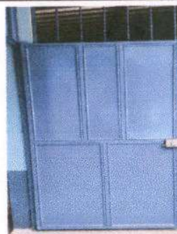
Foto 2: Puerta de lámina por una de metal, medidas de las puertas 2.00 m de altura por 1.00 m de ancho.
