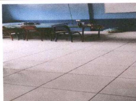
Foto 9: En aula 1, Colocación de piso cerámico debido al deterioro del piso liso. Total de metros 51 m².
