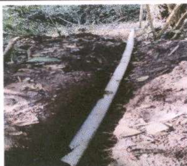
Foto 5: Reparación de red de drenaje tubería principal aguas negras
