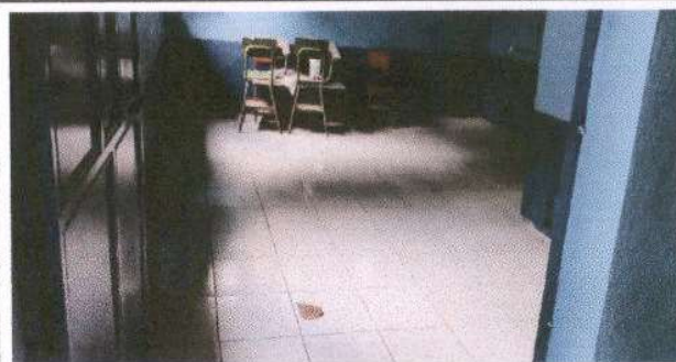
Foto 14: Colocación de piso cerámico ya que se tenia el conveniente de que era torta de cemento y es difícil su aseo. Con total de 22 metros.
